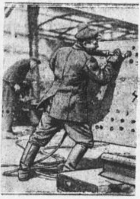
Краматорский металлург. завод. Цех железных конструкций. Пневматическая клепка.
